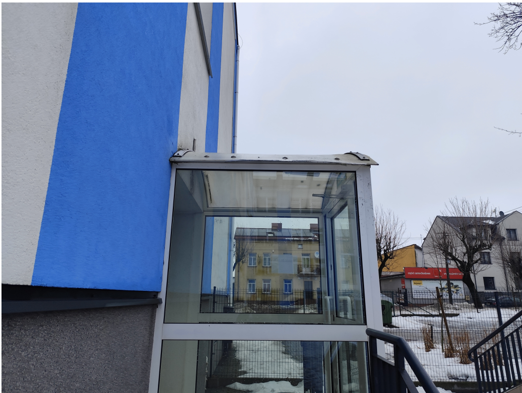
Wymiana pokrycia z płyty poliwęglanowej komorowej gr: 10mm
